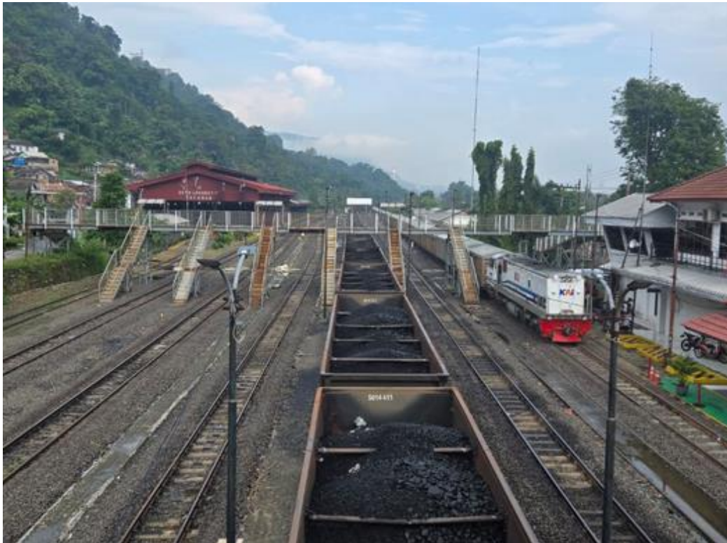
Gambar 1. Kondisi eksisting kereta batubara menuju Stasiun Tarahan.
