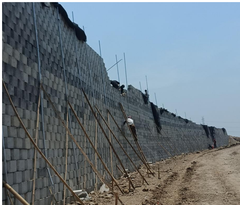
Gambar 3.2 Proses konstruksi MSE wall di kawasan industri jababeka IX
