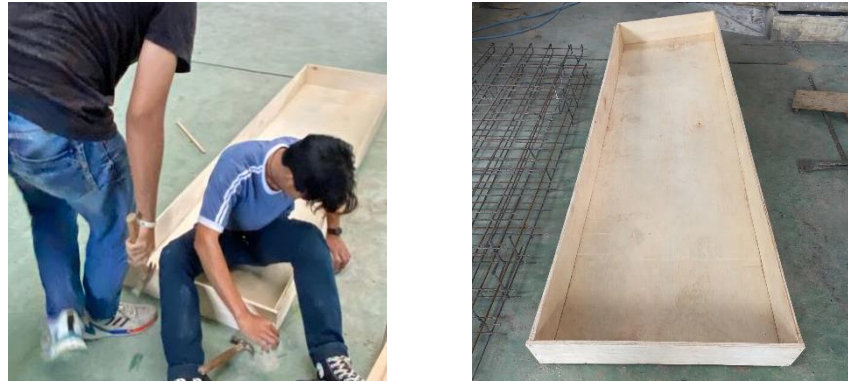
Gambar 3.33. Proses pembuatan bekisting panel beton ringan.
