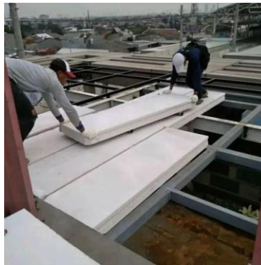
Gambar 2.4. Proses perakitan panel beton ringan.
