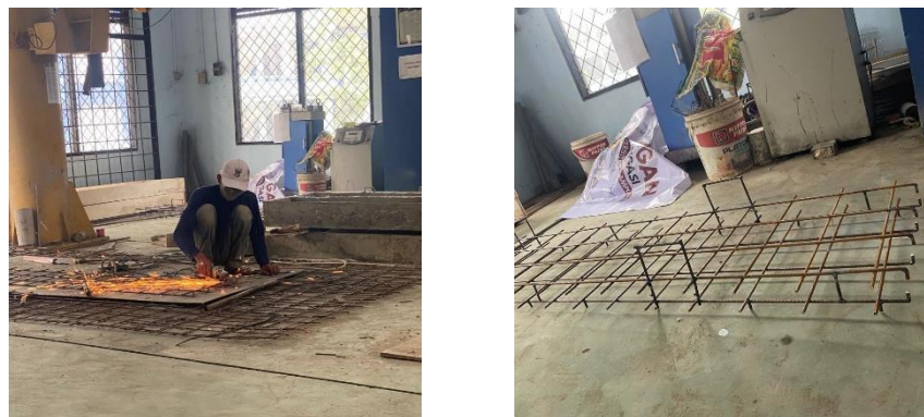
Gambar 3.34. Proses pemotongan dan pengelasan tulangan.
