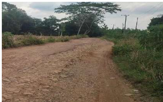
Gambar 4.4 Kondisi Akses SD Negeri 1 Talang Bojong
