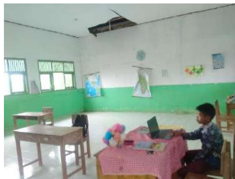
Gambar 4.3 Kondisi Ruang Kelas
