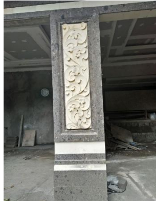
Gambar 2. 13 Kolom Menggunakan Batu Paras ( Sumber: Pinterest, 2026)
