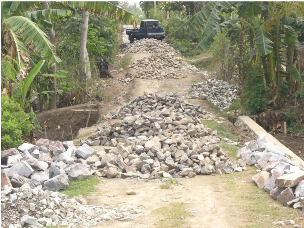
Pembangunan Jalan Onderlah Di Dusun I
