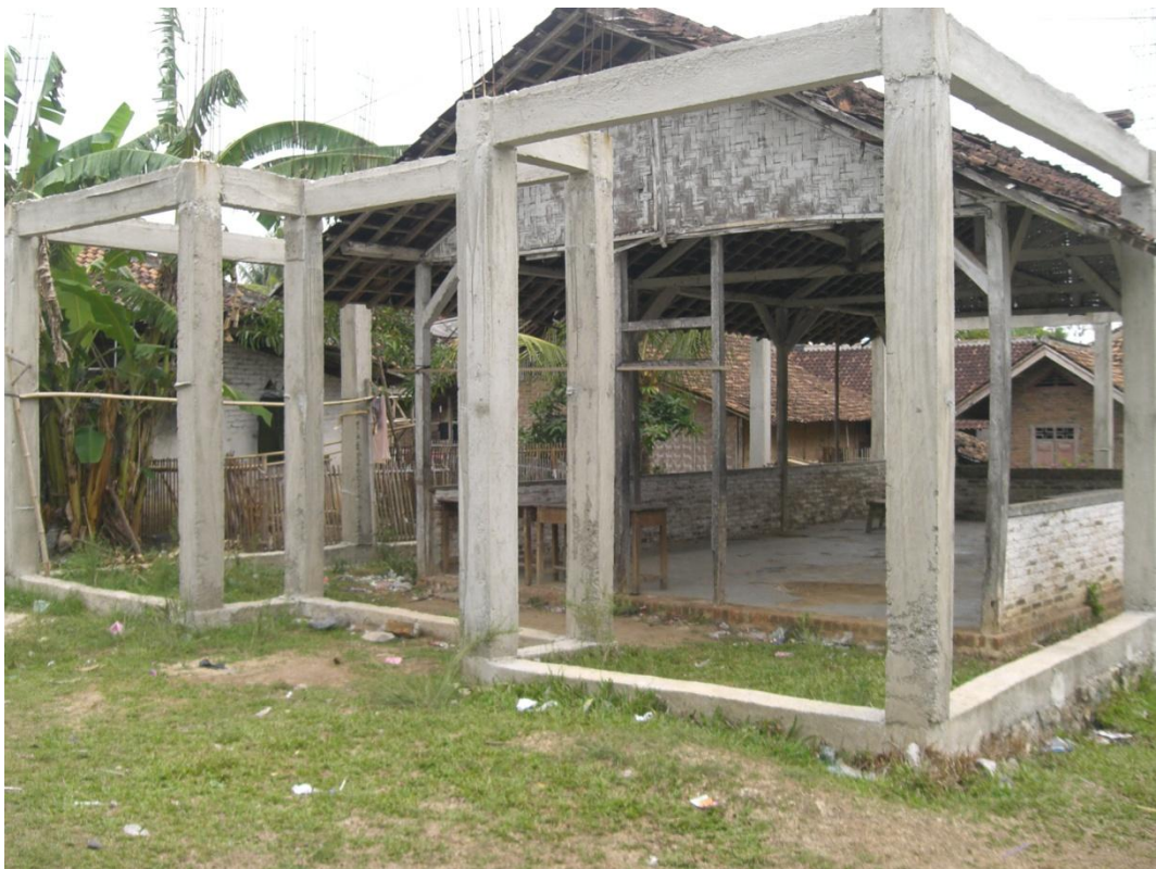
Pembangunan Balai Pekon Gumukrejo Di Dusun I
