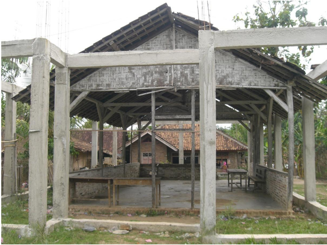
Pembangunan Balai Pekon Gumukrejo Di Dusun I
