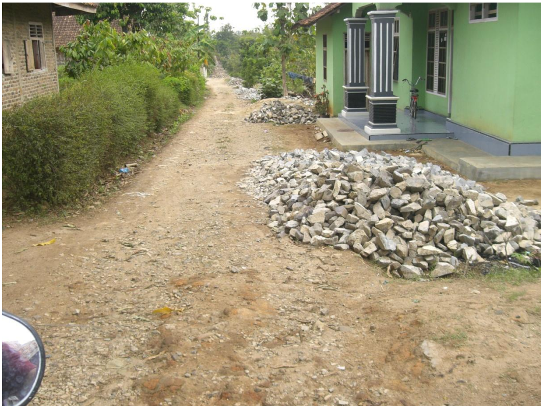
Pembangunan Jalan Onderlah Di Dusun I
