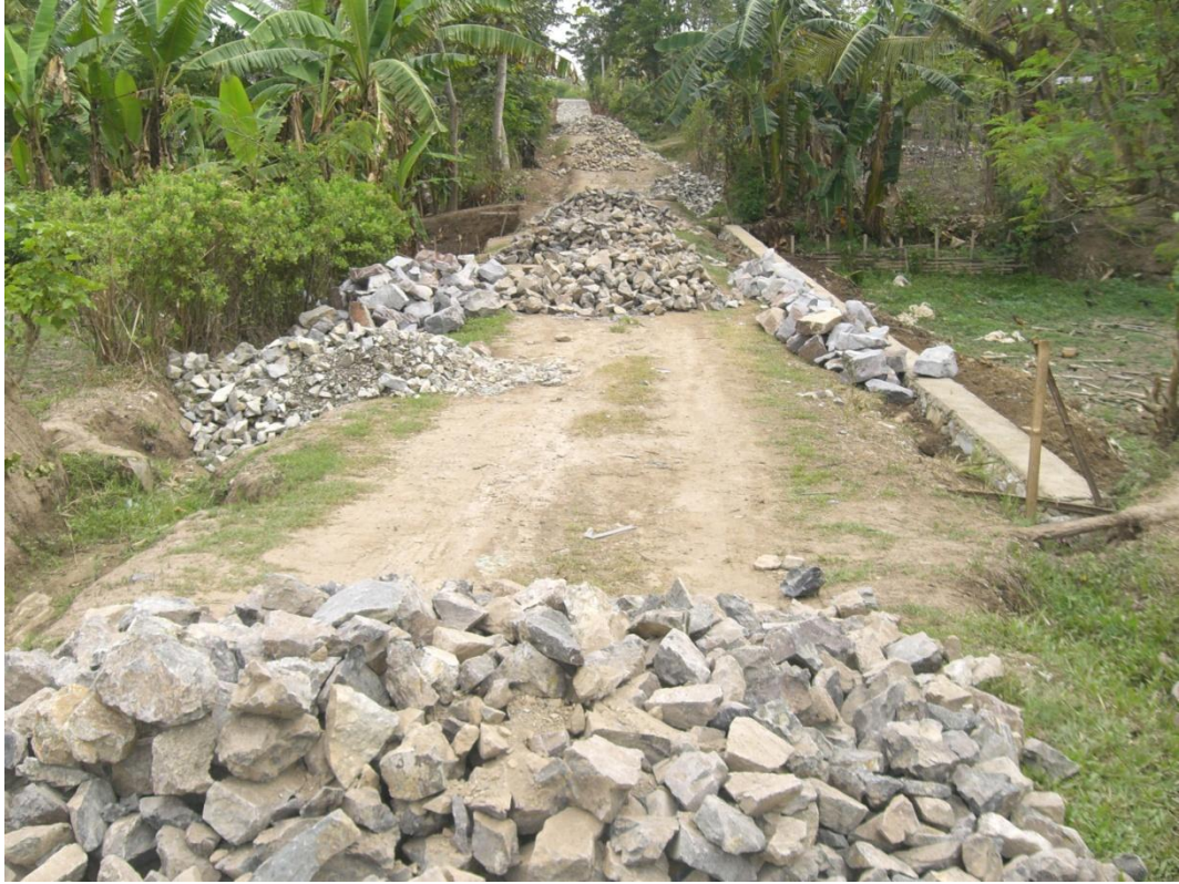
Pembangunan Jalan Onderlah Di Dusun I
