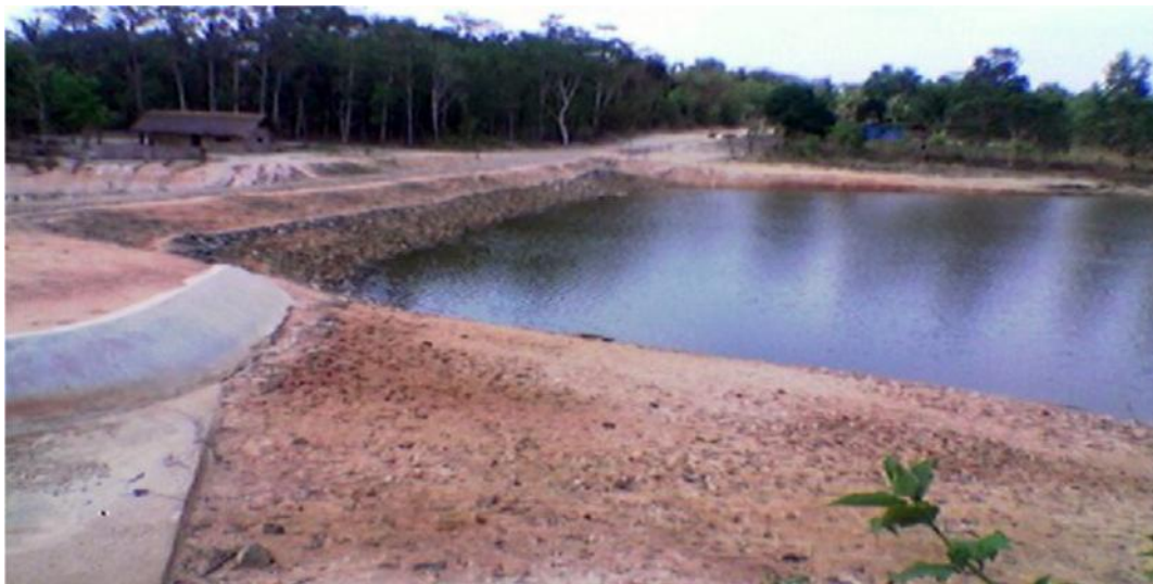
Gambar 4 Pembangunan Embung di Wilayah Balai Besar Sungai Way Mesuji Provinsi Lampung
