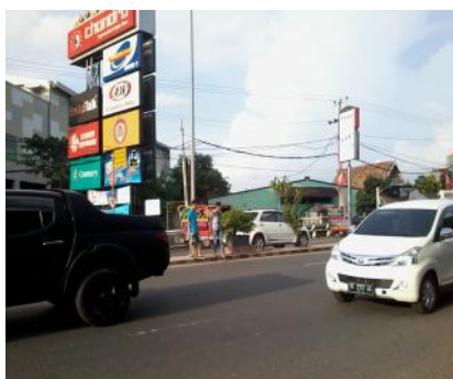
( Gambar 2. Kondisi Jalan Teuku Umar )
