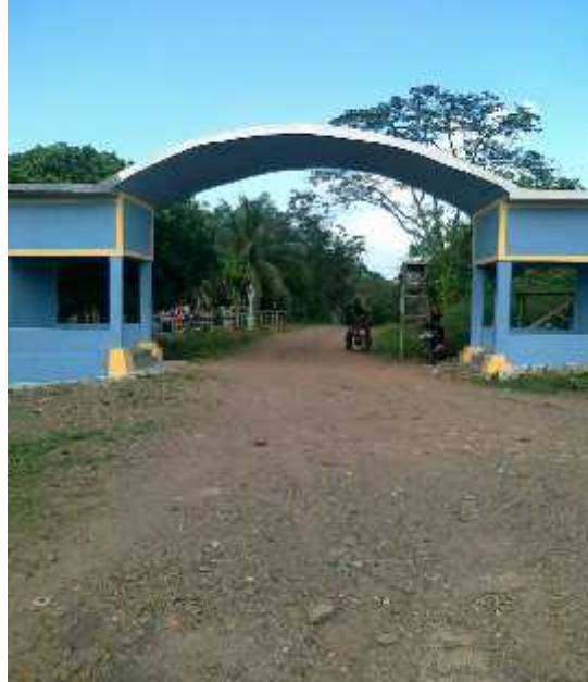
Gambar 22. Kondisi Jalan yang Menghubungkan Ke Permukiman
