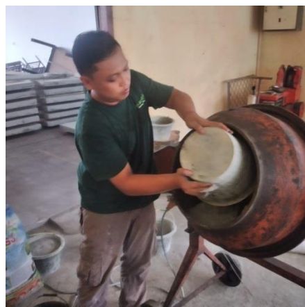
Gambar 31. Pecampuran bahan dengan mesin molen
