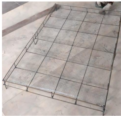
Gambar 14. Penulangan panel fero semen
