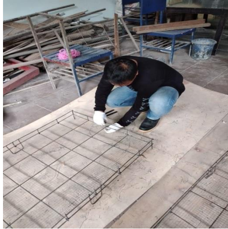
Gambar 36. Memasang kawat ayam pada tulangan panel
