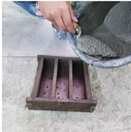
Gambar 32. Memasukkan campuran mortar kedalam cetakan
