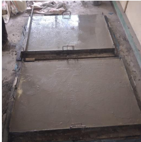
Gambar 38. Memasukkan campuran ferosemen pada cetakan.
