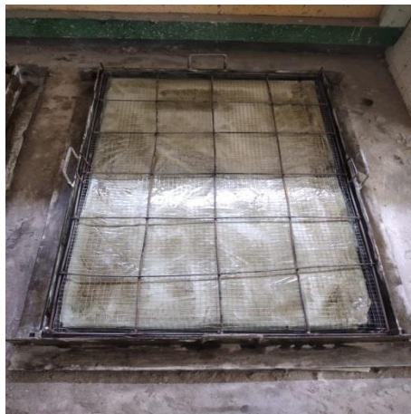
Gambar 37. Meletakkan rangkaian tulangan pada cetakan.
