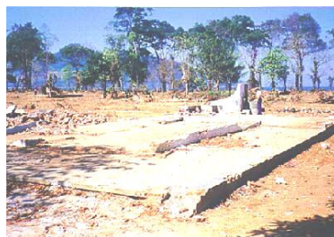
Kerusakan pemukiman (Kampung Pancer –Tsunami 94)
