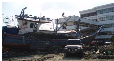
Kerusakan harta benda (Tsunami Aceh 2004)
