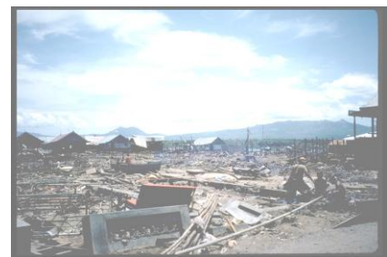
Kerusakan pemukiman (Maumere 1992)
