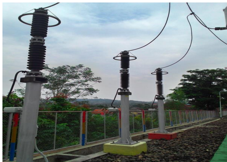
Gambar 2.5. Arrester Gardu Induk Teluk Betung
