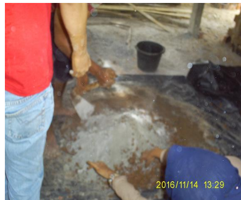
Pencampuran Material Tanah
