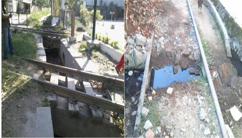
**Gambar 8. Kondisi Jalan KA Diatas Saluran Air Sehingga Dibutuhkan Desain *Box Culvert* dan Jalan KA yang Dilintasi Saluran Air Dibutuhkan Desain *Open Doorlagh***
