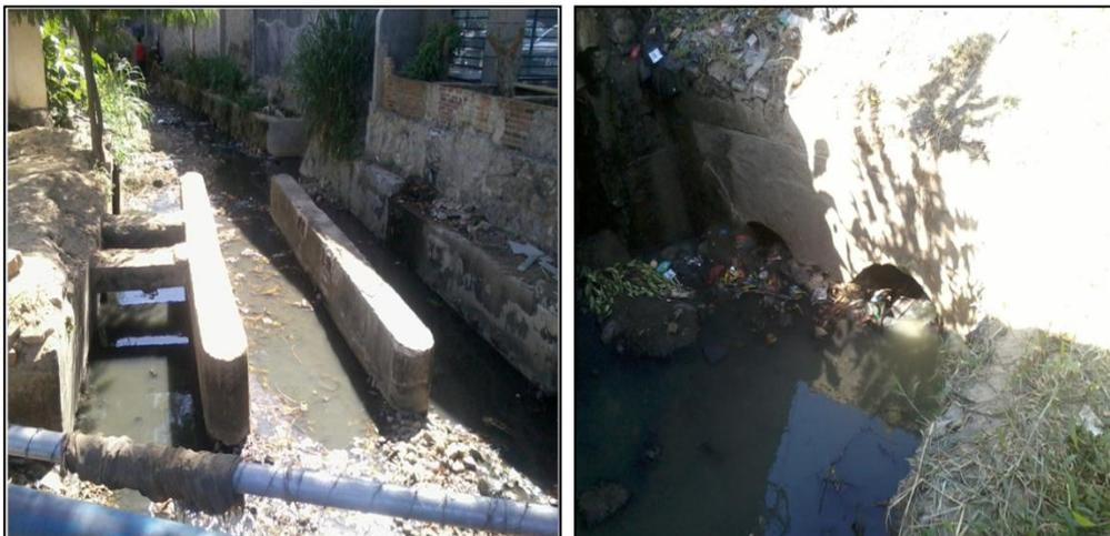
**Gambar 7. Kondisi Jembatan KA yang Tidak Digunakan Lagi dan Kondisi *Box Culvert* yang Tidak Berfungsi dengan Baik**
