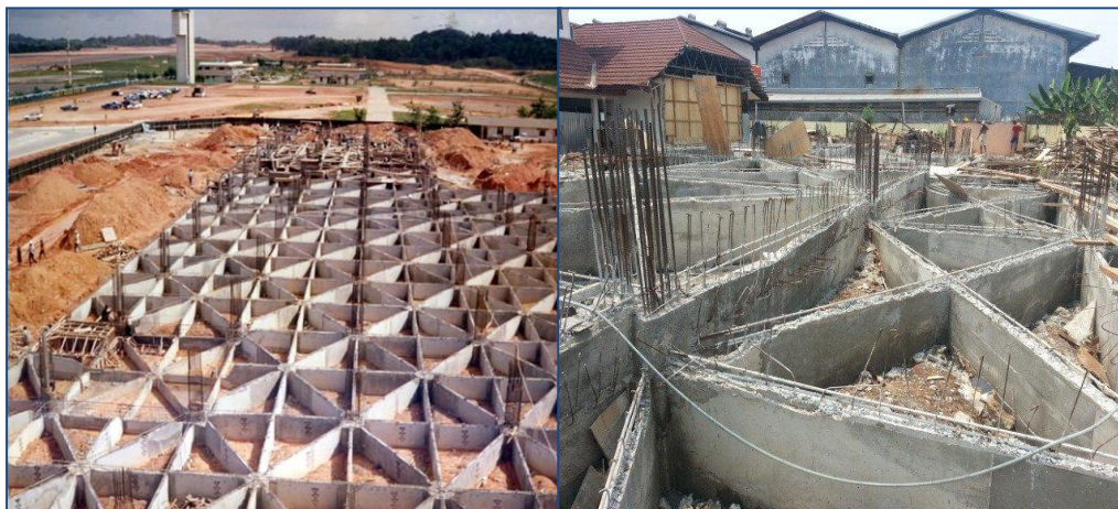
Gambar 1. Pondasi Konstruksi Sarang Laba-laba (KSSL)
