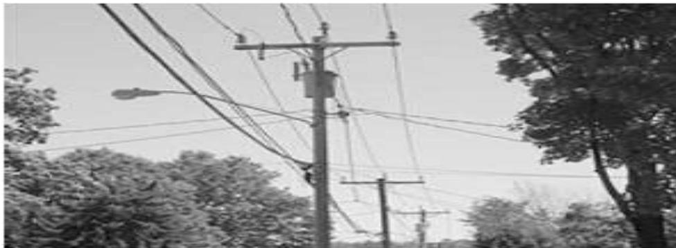
Gambar 2.2. Saluran udara tegangan menengah (SUTM)<sup>[2]</sup>
