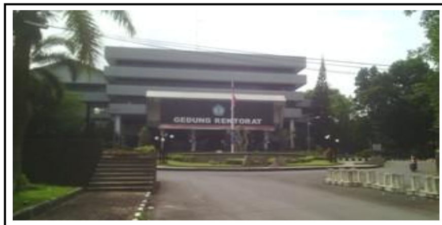
Gambar 22. Gedung Rektorat Universitas Lampung
