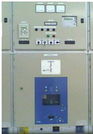
Gambar 2.11 Kubikel Penyulang/Outgoing 20 kv (foto pada GI New Tarahan, atas seizin PT PLN Persero)
