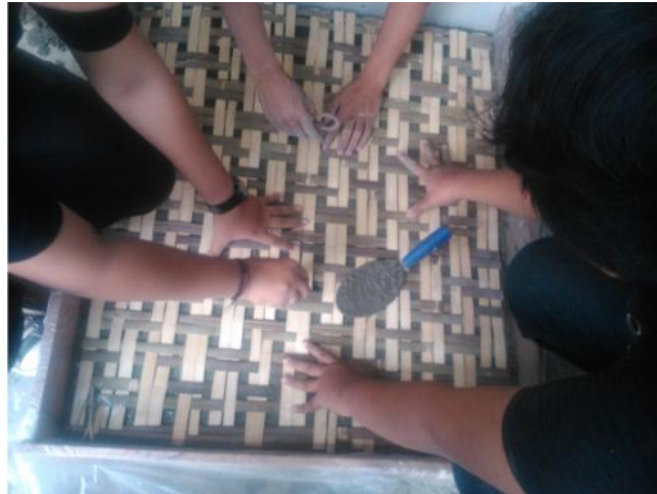
Gambar 10. pemasangan tulangan bamboo pada ketebalan 3 cm dan 5 cm lalu setelah itu di tuangkan lagi agregat sampai tinggi 8 cm sesuai dengan tinggi matras beton rencana. Dan beton dibiarkan dulu sampai 21 hari agar tercapai kuat optimal matras beton.
