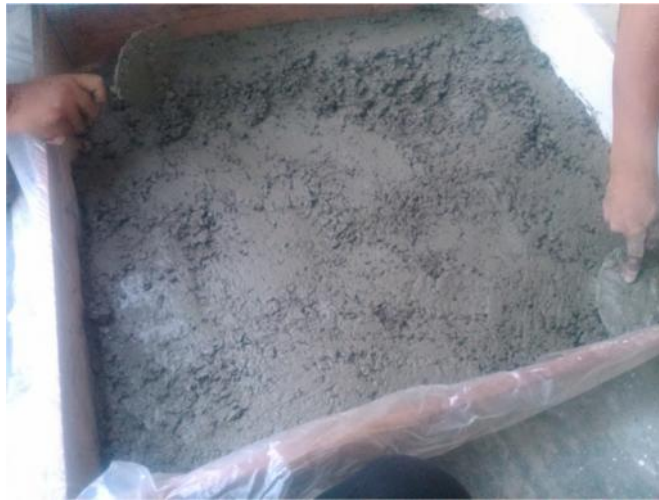
Gambar 9. memasukan agregat pada bekisting matras beton
