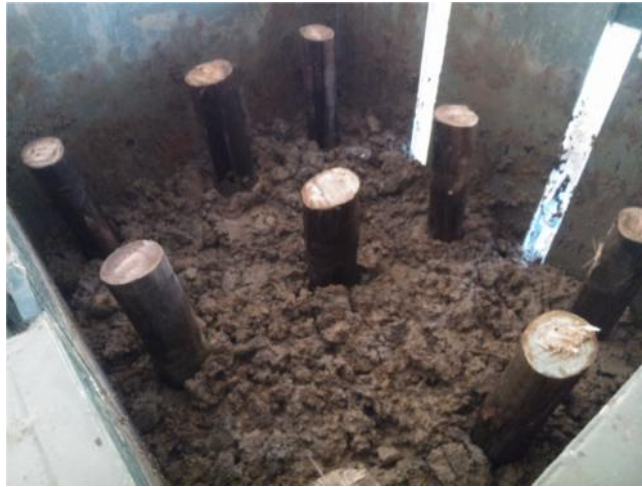
Gambar 14. pemasangan tiang kayu
