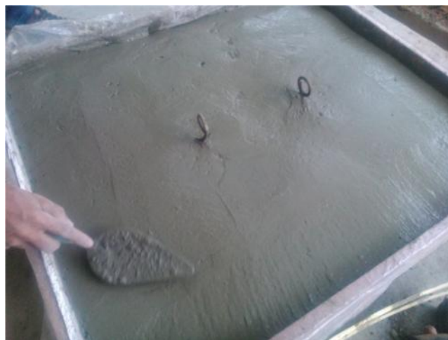
Gambar 11. matras beton bamboo setelah dilakukan pengecoran
