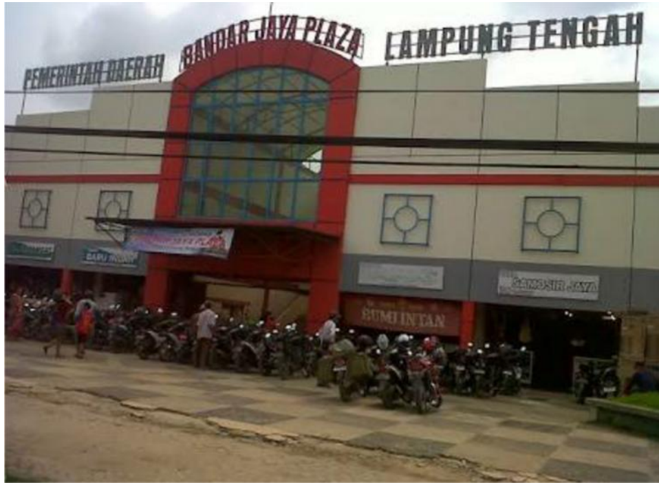
Gambar 5. Tempat Parkir Bandar Jaya Plaza Pintu Masuk Bagian Depan
