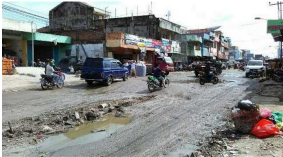
Gambar 4. Kondisi Jalan Rusak Bandar Jaya Plaza
