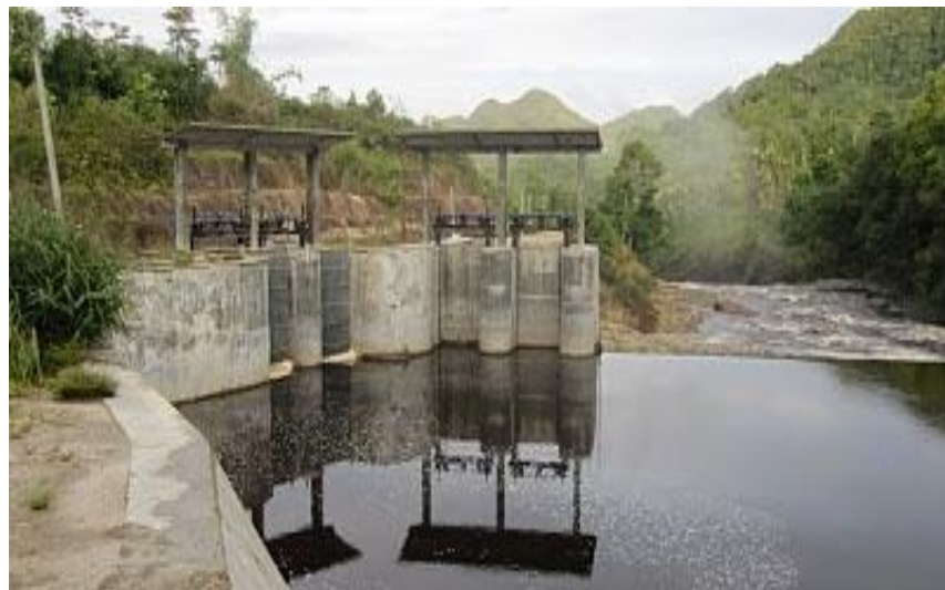
Gambar 2.3. Bangunan penyadap air ( intake ) (Laymand, 1998).
