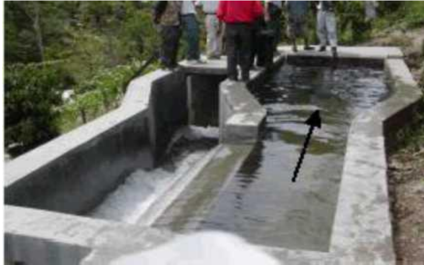
Gambar 2.5. Penyaring ( trashrack ) dan Bak penenang ( forebay ) (Laymand, 1998).
