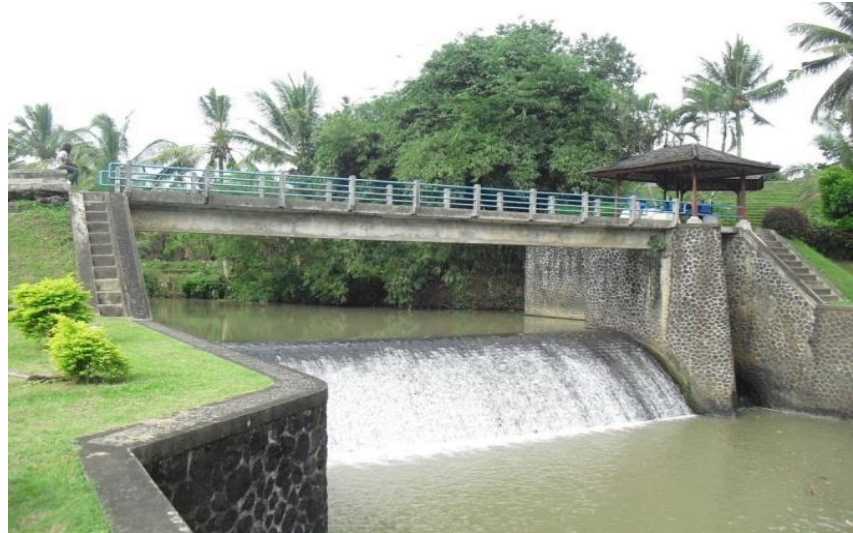
Gambar 2.2. Bendung ( weir ) (Laymand, 1998).
