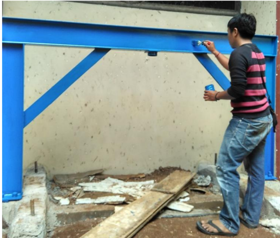
Gambar 3.17. Proses Pengecatan Rangka Uji
