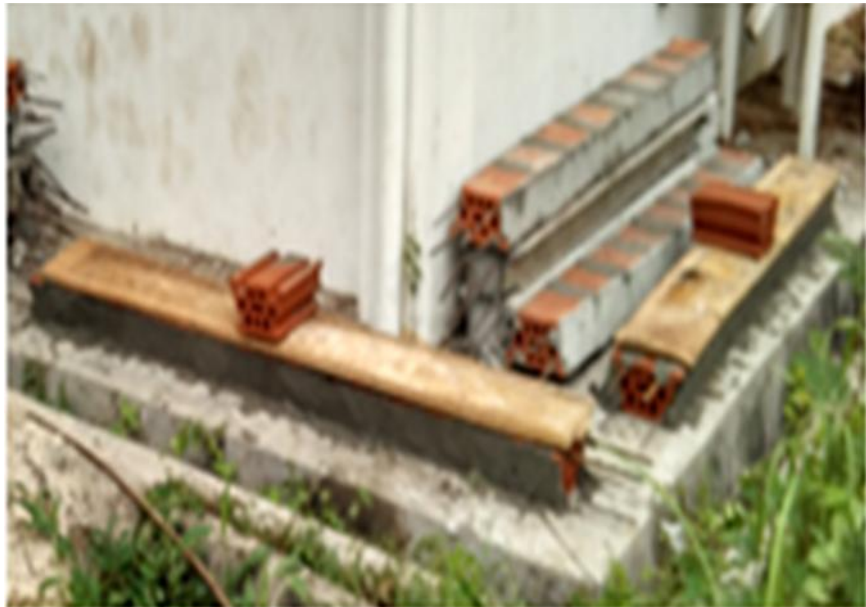
Gambar 3.9 pemasangan keraton dengan semen dan pasir
