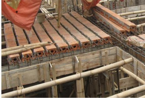
Gambar 1.1. Balok Material Keramik Komposit (sumber : http://dakbetonkeraton.com )
