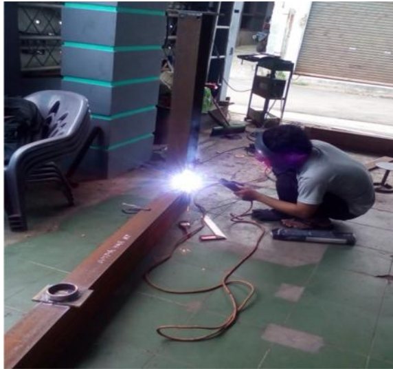
Gambar 3.13. Pengelasan Keseluruhan Untuk Penyambungan Permanen
