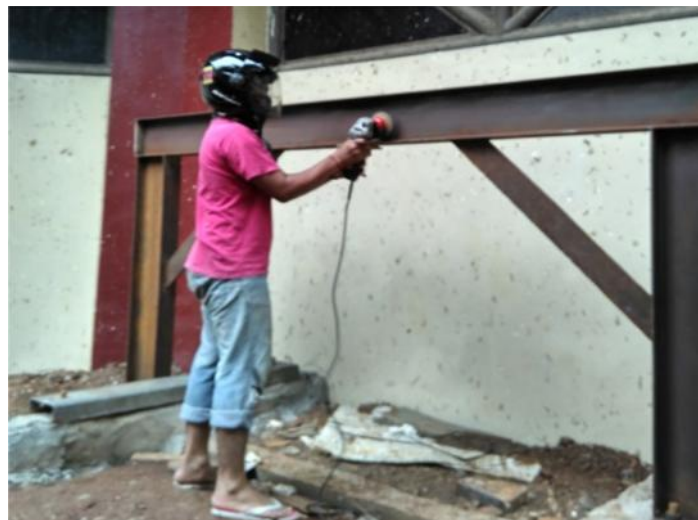
Gambar 3.16. Proses Pengamplasan Rangka Uji
