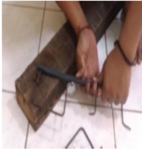
Gambar 3.3. Proses Pembuatan Besi Cincin
