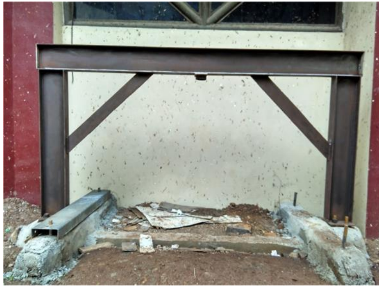
Gambar 3.15. Pemasangan Rangka Uji Pada Pondasi
