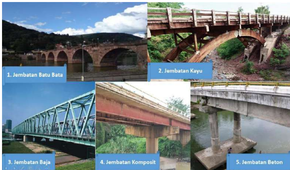
Gambar 2.1. Jenis jembatan ditinjau dari bahan bangunannya.
