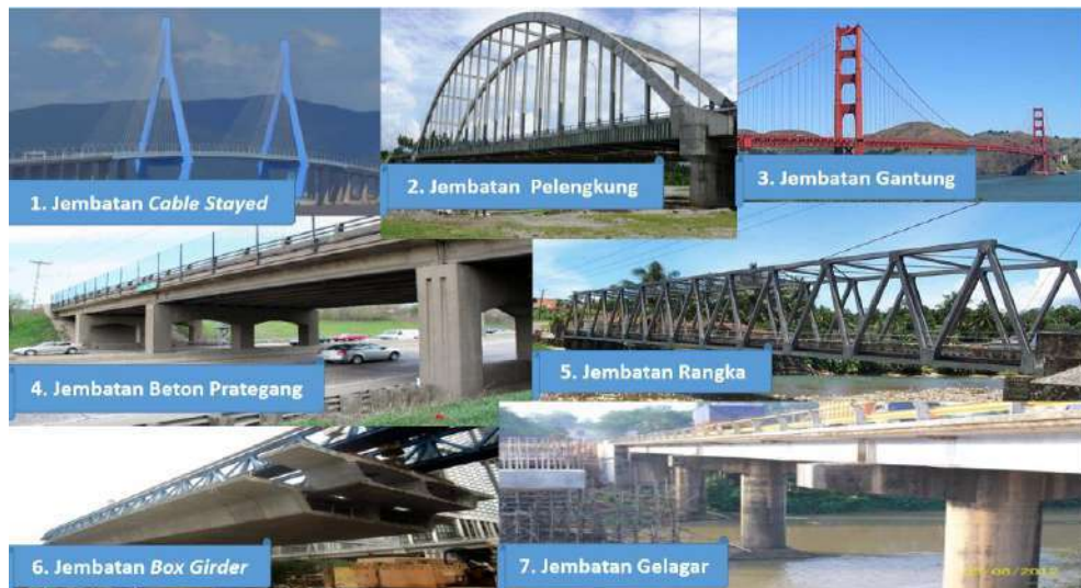
Gambar 2.3. Jenis-jenis jembatan berdasarkan sistem struktur.
