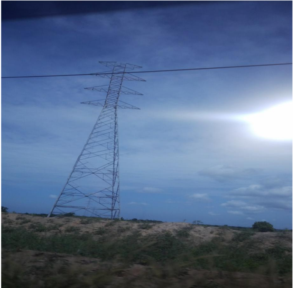
Keterangan: Tiang SUTET (Saluran Udara Tegangan Ekstra Tinggi)
