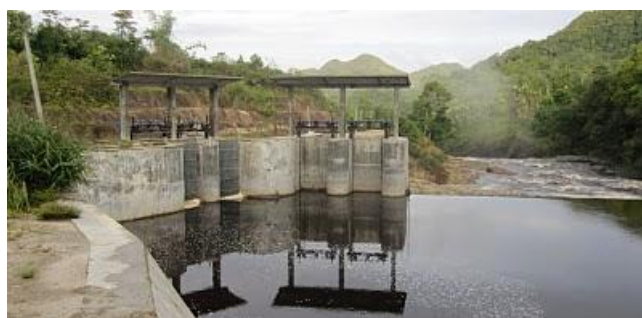
Gambar 3. Bendungan ( weir ) dan intake (Laymand, 1998)
