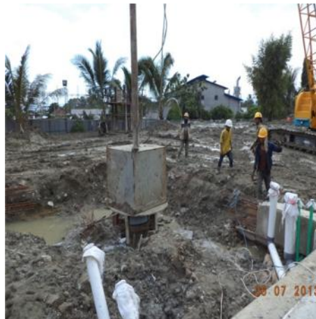
Gambar 2. Pengujian dengan Alat PDA ( Pile Driving Analyzer )
