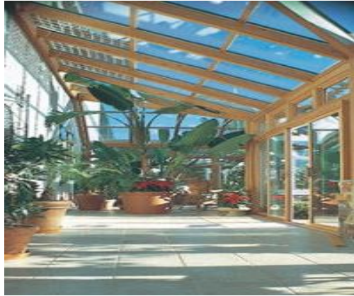
Gambar 2.11. Deretan Modul PV sebagai penutup SunSpace, memasukkan cahaya alami sambil mendapatkan listik surya (PV Glass-Modules pada SunSpace) (Mintorogo, 2000)
