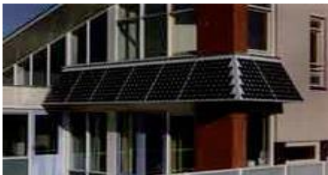
Gambar 2.10. Modules PV pada Overstack Rumah (Mintorogo, 2000)
