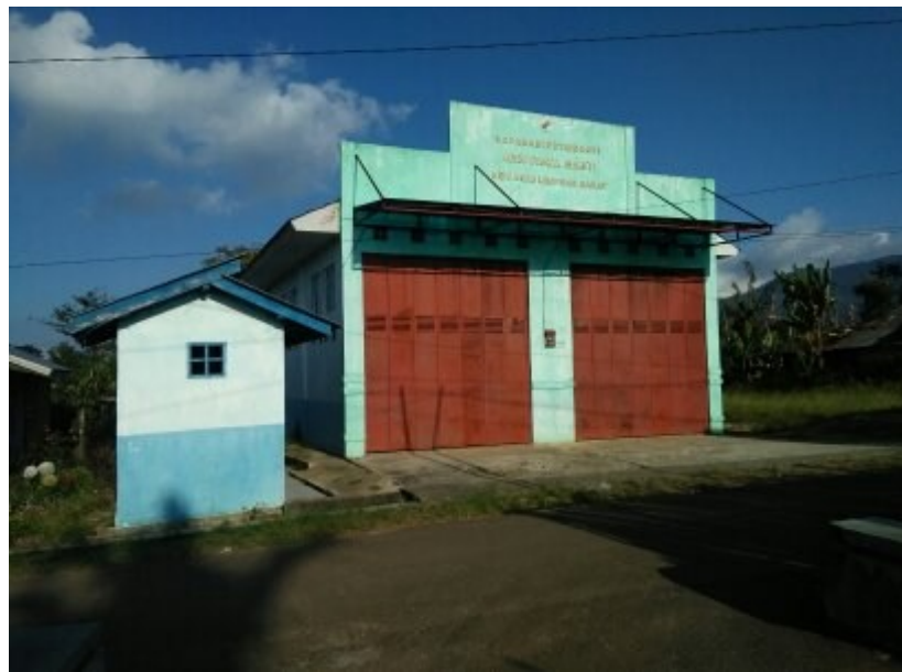
Gambar 5. Bangunan Koperasi Agro Panca Bhakti
