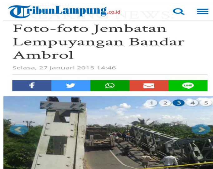
Gambar 3. Foto Jembatan Putus di Lempuyang Bandar
