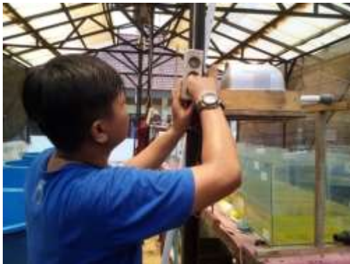
Pemasangan instalasi blower
