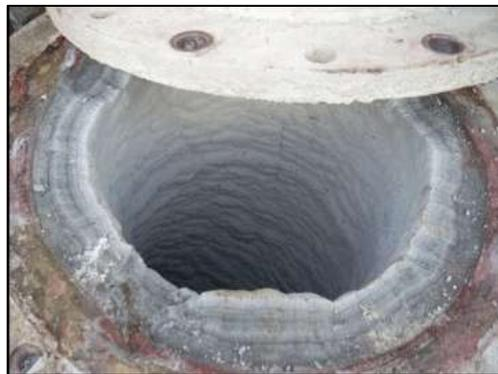
Gambar 2. Kerak  $\text{CaCO}_3$  dalam pipa industri (Haklidir and Mehmet, 2017).
