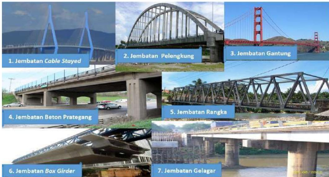
Gambar 2.3 Jenis-jenis jembatan berdasarkan sistem struktur.
