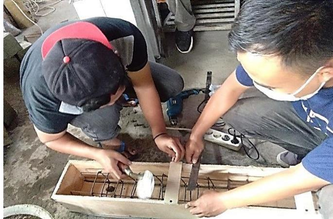
Gambar 4.3 Pemasangan pengaku di sisi pinggir.
