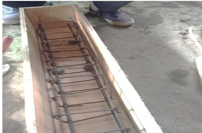
Gambar 4.2 Pemasangan tulangan kedalam bekisting.
