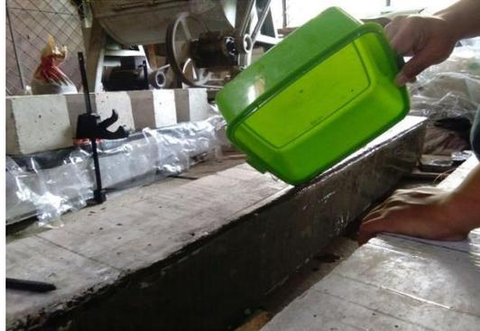
Gambar 4.13 Penempelan perkuatan pada balok.
