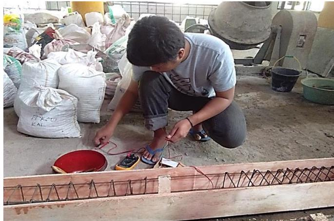
Gambar 4.4 Bekisting yang siap digunakan.
