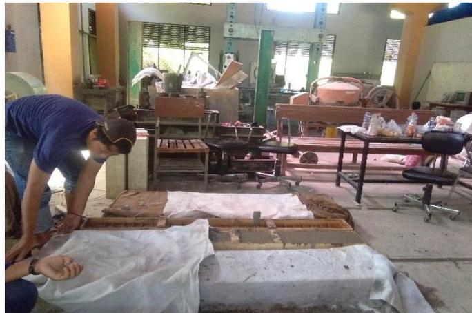
Gambar 4.10 *Curing* dengan menggunakan *geotextile*.
