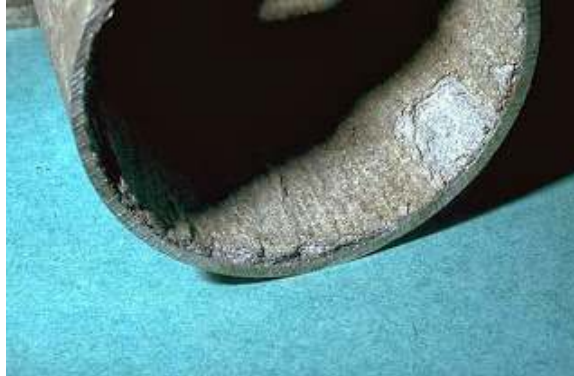
Gambar 7. Korosi batas butir pada pipa (Budianto dkk, 2009)
