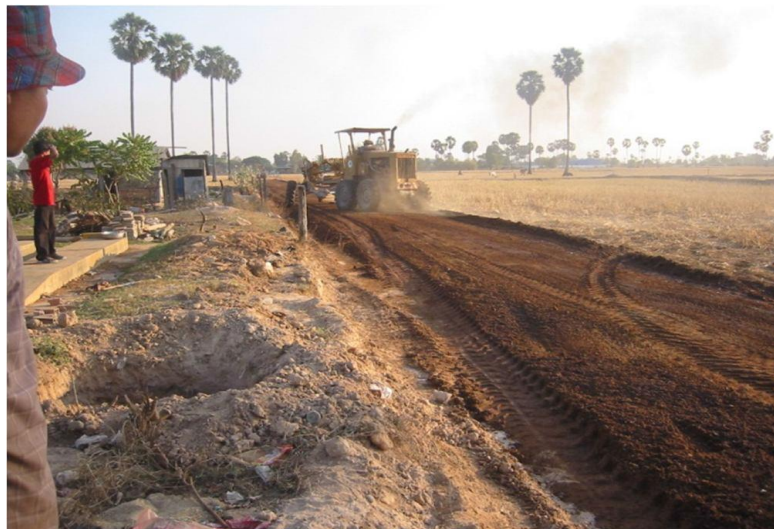
Gambar.3 Proses Pemadatan Tanah Dengan Menggunakan Compactor
