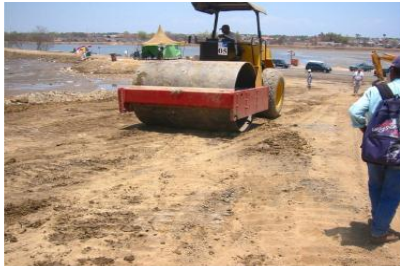
Gambar 4. Proses Pematatan dan curing
