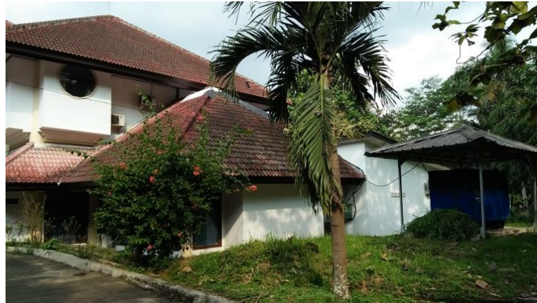
Gambar 13 Tampak Samping Gedung Jurusan Matematika.
