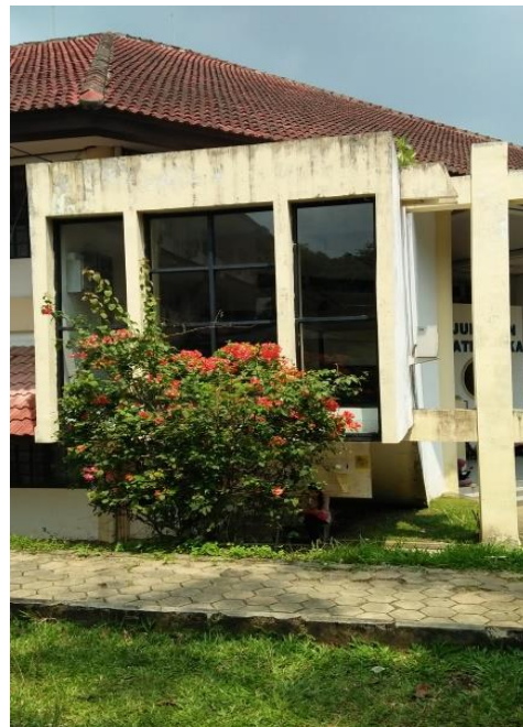
Gambar 14 Tampak Samping Gedung Jurusan Matematika.
