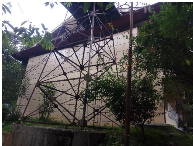
Gambar 21 Tampak Belakang Gedung Zoologi Jurusan Biologi.
