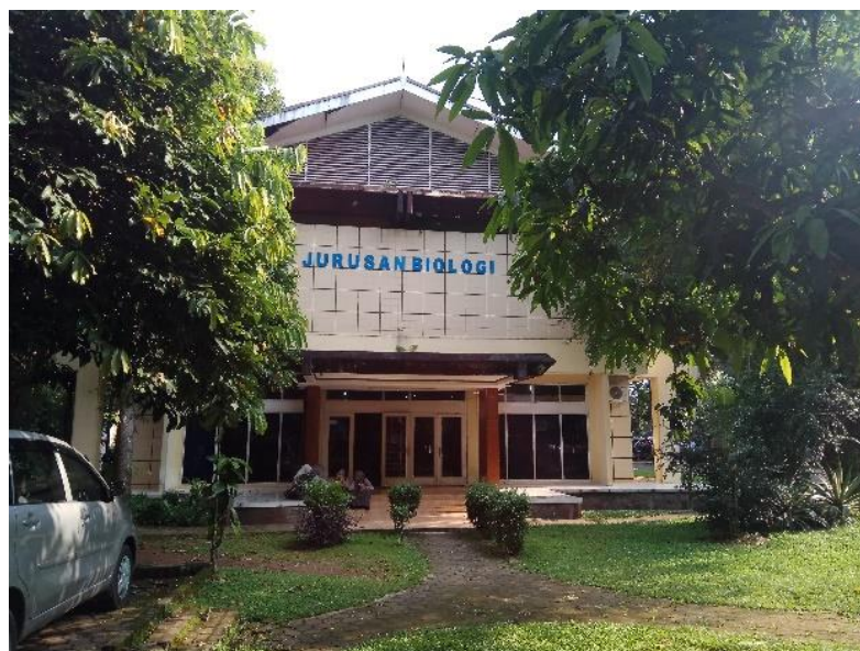
Gambar 18 Tampak Depan Gedung Zoologi Jurusan Biologi.
