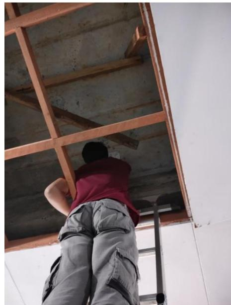
Gambar 10. Pengujian Balok dengan Hammer Test.
