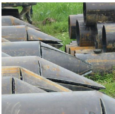
Gambar 2.12. Fondasi tiang pancang pipa baja.
