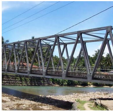
Gambar 2.3. Tipe jembatan rangka baja.
