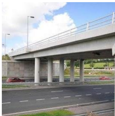
Gambar 2.1. Tipe jembatan beton.
