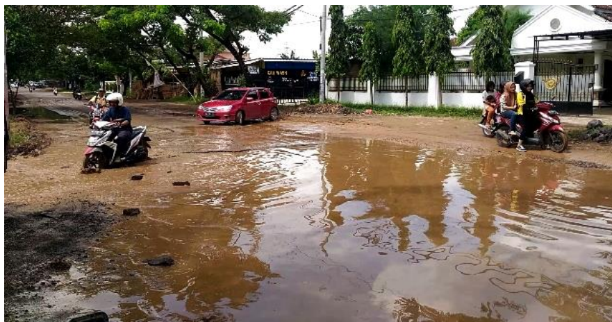
Gambar 1. kondisi jalan Ryacudu (Selasa, 30 April 2019) ( sumber: artikel berita www.kupastuntas.co )
