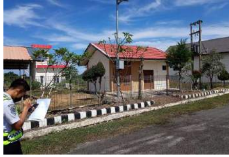
Gambar 2.10. Power house pada Bandara Muhammad Taufik Kiemas Sumber : Dokumentasi penulis
