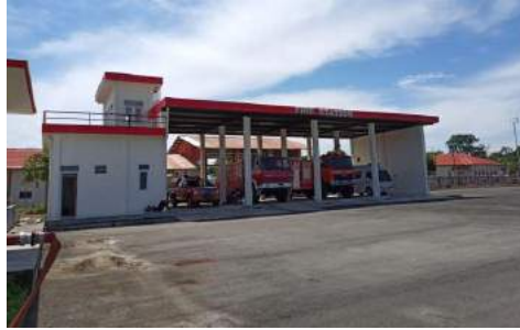
Gambar 2.8. Bangunan PKP-PK pada Bandara Muhammad Taufik Kiemas
