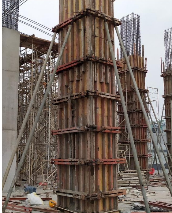
Gambar 3.23. Bekisting Sumber: Dokumentasi Lapangan
