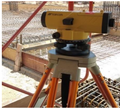
Gambar 3.20. Waterpass Sumber: Dokumentasi Lapangan
