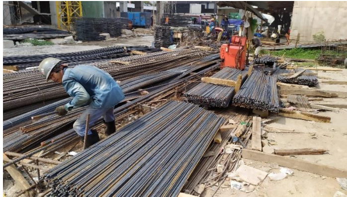
Gambar 3.1. Besi Tulangan Sumber: Dokumentasi Lapangan
