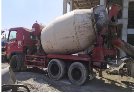
Gambar 3.2. Beton Ready Mix Sumber: Dokumentasi Lapangan
