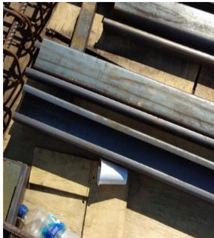
Gambar 3.6. Besi CNP Kanal C Sumber: Dokumentasi Lapangan
