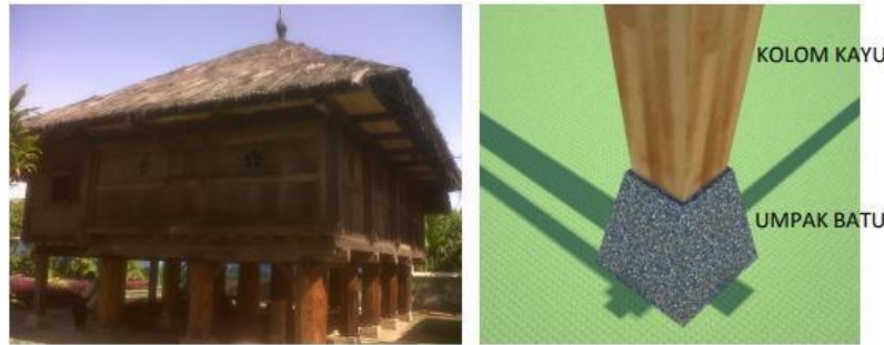
Gambar 2.59 Rumah Tradisional Kenali Dan Pondasi Umpaknya Sumber: Ibrahim, 2011
