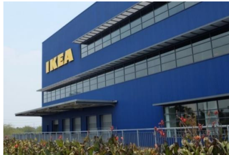
Gambar 2. 15 Fasad Bagian Selatan
