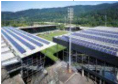
Gambar 2.26. Contoh Aplikasi struktur PV ekspos pada atap stadion Source : scmp.com
