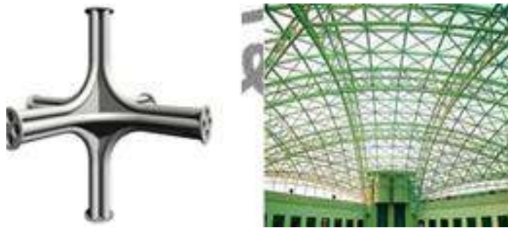
Gambar 2.30. Detail Penyambung Pada Space Frame
