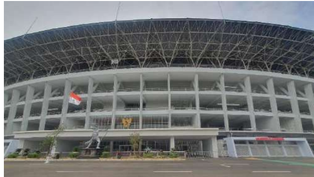
Gambar 2.61. Fasad terbuka dan pengeksposan struktur Stadion GBK Sumber: Dokumentasi Pribadi
