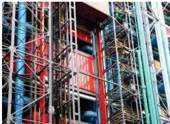
Gambar 2.17. Ekspos Elemen Servis Pada Bangunan Berarsitektur Hi-Tech Sumber : pompindoecenter/diakses maret 2015
