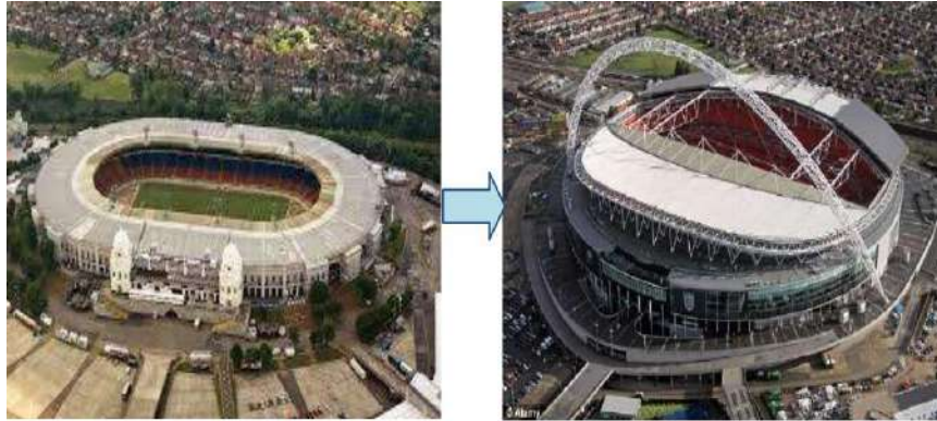
Gambar 2.44. Wembley Stadium Sebelum dan Sesudah Renovasi Sumber : Wikipedia.com
