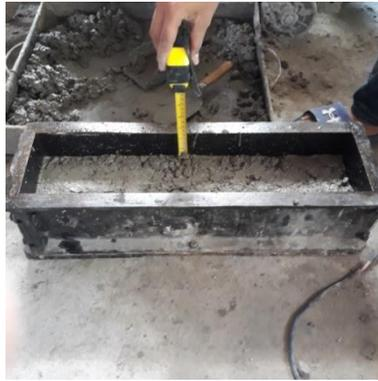
Gambar 3. Pengecoran lapis *substrate*.
