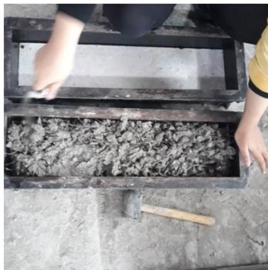
Gambar 4. Pengecoran lapis *overlay*.
