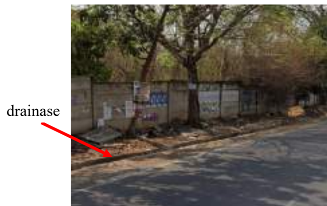
Gambar 5.13 Drainase Pada Tapak
