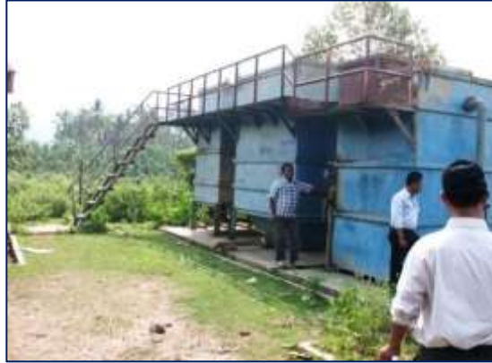
Gambar 10. IPA Banyumas Kapasitas 5 Liter/dt.
