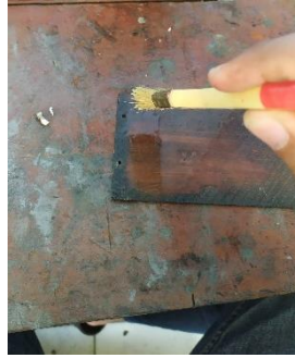
Gambar 3.16. Pelapisan kotak perisai dengan cat konduktif
