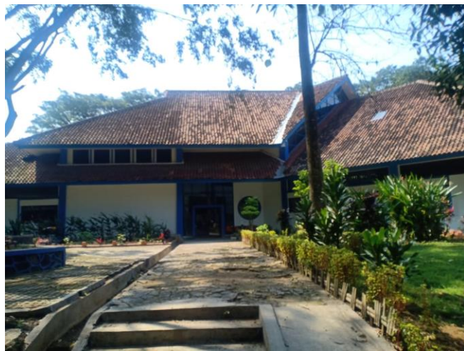
Gambar 15. Bagian belakang Gedung F Laboratorium Hidrolika.
