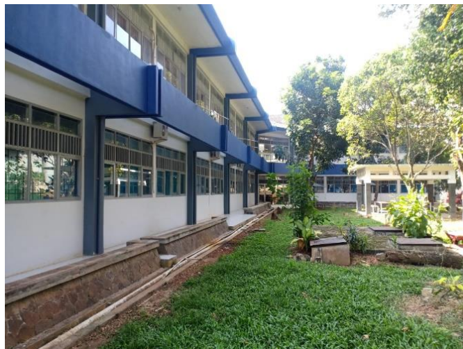
Gambar 17. Bagian Belakang Gedung E Teknik Sipil
