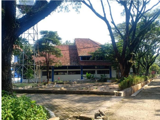
Gambar 14. Bagian samping Gedung F Laboratorium Hidrolika
