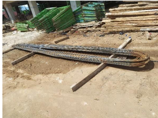
Gambar 3.1 Besi Tulangan Sumber : Dokumentasi Penulis.
