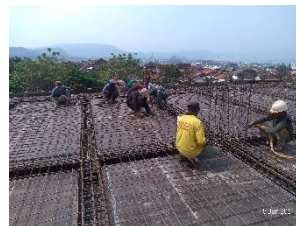
Gambar 3.48 Pemasangan Plat Lantai.
