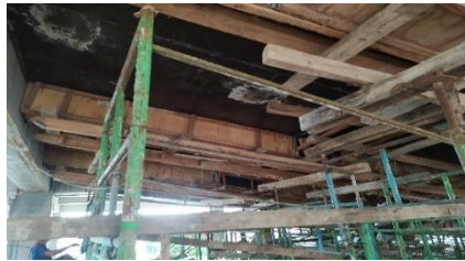
Gambar 3.33 Bekisting Plat Lantai. Sumber : Dokumentasi Penulis.
