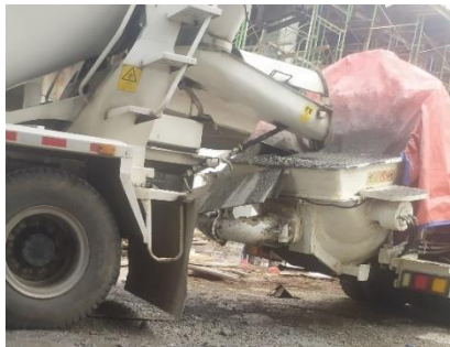
Gambar 3.5 Beton Ready Mix . Sumber : Dokumentasi Penulis.
