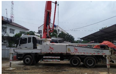
Gambar 3.27 Concrete Pump Truck Sumber: Dokumentasi Penulis
