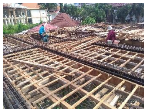
Gambar 3.47 Pemasangan bekisting Plat Lantai.
