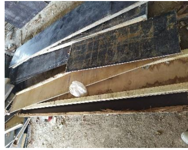
Gambar 3.32 Bekisting Balok. Sumber : Dokumentasi Penulis.
