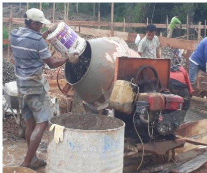
Gambar 3.25 Adukan Beton. Sumber : Dokumentasi Penulis.
