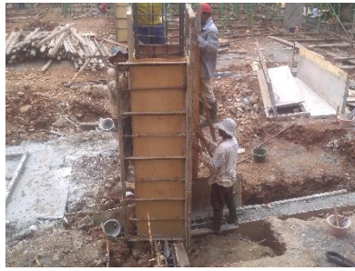
Gambar 3.31 Bekisting kolom. Sumber : Dokumentasi Penulis.
