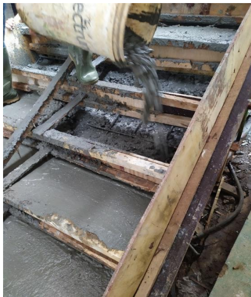
Gambar 3.56 Pengecoran Tangga. Sumber : Dokumentasi Penulis.
